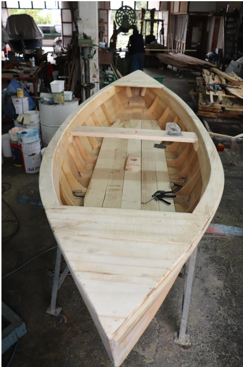
Εικ. 17: Η τοποθέτηση των διπύθμενων (φάρσια).
